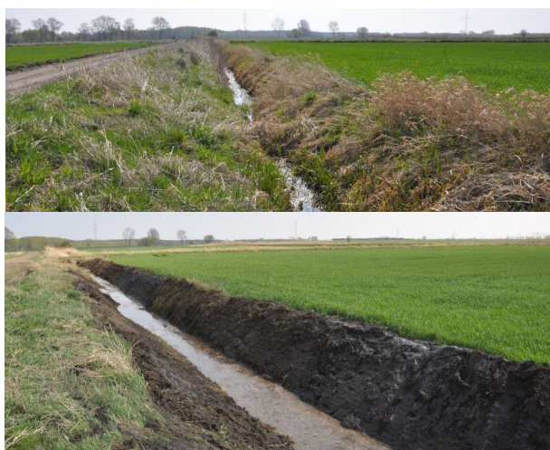
Fig. 3. Condition of watercourse; the photo at the top shows a ditch before milling the slopes, and below the photo shows a ditch after milling the slopes Rys. 3. Stan ciek melioracyjnego; zdjęcie na górze pokazuje rów przed kształtowaniem skarp, zdjęcie poniżej pokazuje ciek po kształtowaniu skarp
