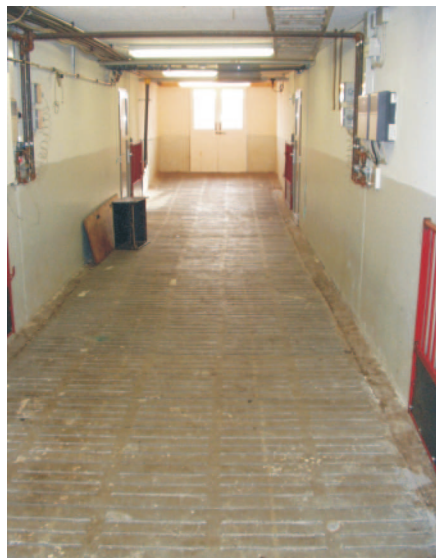
Rys. 8. Oświetlenie korytarza (fot. WJW).
