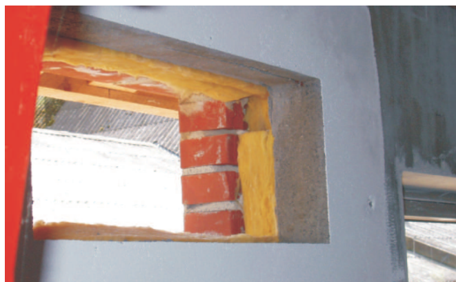
Rys. 1. Otwór okienny w trakcie budowy chlewni (fot. WJW) Fig. 1. Window opening during piggery constructing
