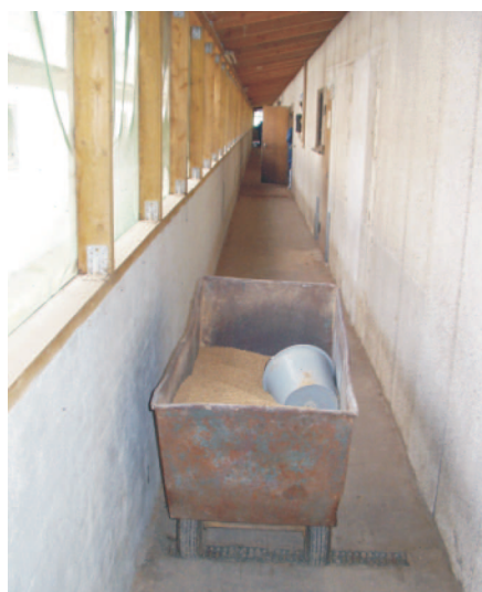
Rys. 9. Oświetlenie korytarza do transportu paszy i do nadzoru zwierząt (fot. WJW)
