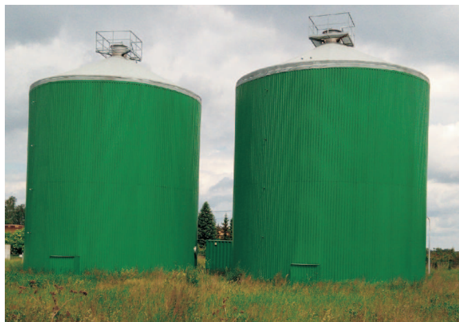
Rys. 3. Stalowe zbiorniki fermentacyjne Fig. 3. Steel fermentation tanks
