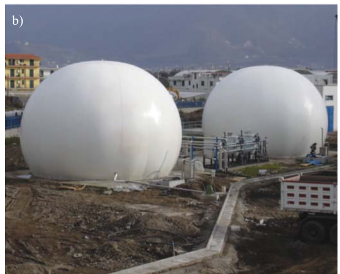
Rys. 1. Półsferyczny kształt zbiornika biogazu (a) oraz zbiornik biogazu o kształcie \frac{3}{4} sfery (b) [7]
