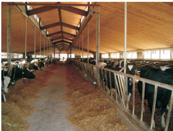
Rys. 4. Wnętrze obory po modernizacji Fig. 4. The interior of the barn after modernization
