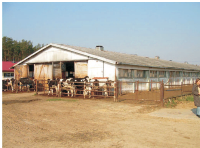
Rys. 7. Widok na oborę przed modernizacją Fig. 7. View of the barn before modernization
