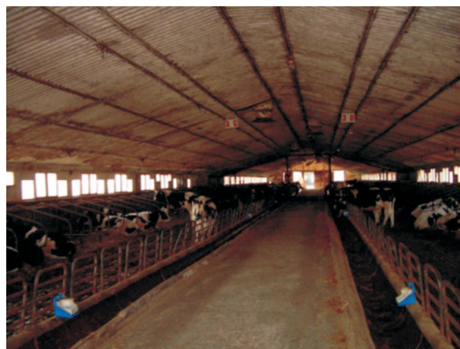
Rys. 3. Wnętrze obory przed modernizacją
