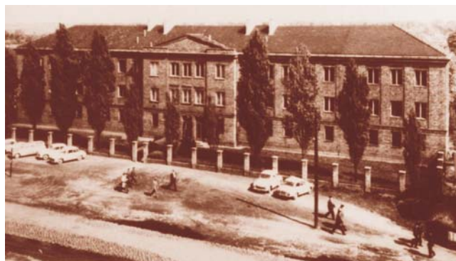
Rys. 3. Siedziba Instytutu Maszyn Rolniczych we własnym budynku przy ul. Starołęckiej 31 w Poznaniu (stan z 1953 r.)
