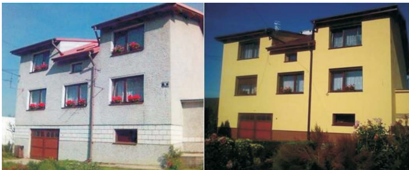
Rys. 1. Analizowany budynek mieszkalny jednorodzinny przed i po termomodernizacji
