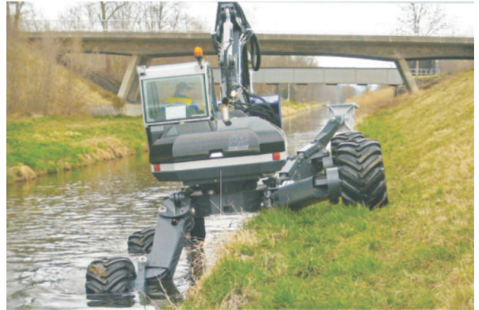
Rys. 4. Maszyna podczas pogłębiania kanału wodnego (fot. firmowa)
