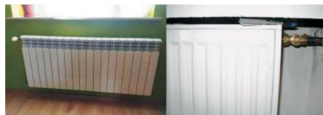
Rys. 3. Usytuowanie grzejników oraz przykład niewłaściwego sposobu montażu grzejnika płytowego Fig. 3. Location of radiators and an example of incorrect installation of a panel radiator
